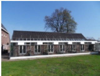
Glasstrook aan voorkant oude duivenhok
